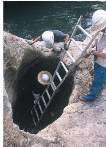
排水枡内の埋土掘り下げ状況
