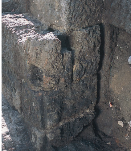
放水口の堰板溝（左） 導水溝の堰板溝（右）
